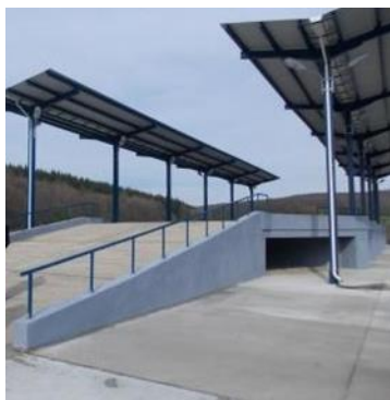
Figură 4-1 Stație de transfer
