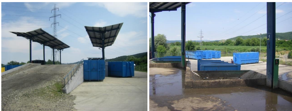
Figură 2-7 Stația de transfer și Centrul de colectare Beclean
