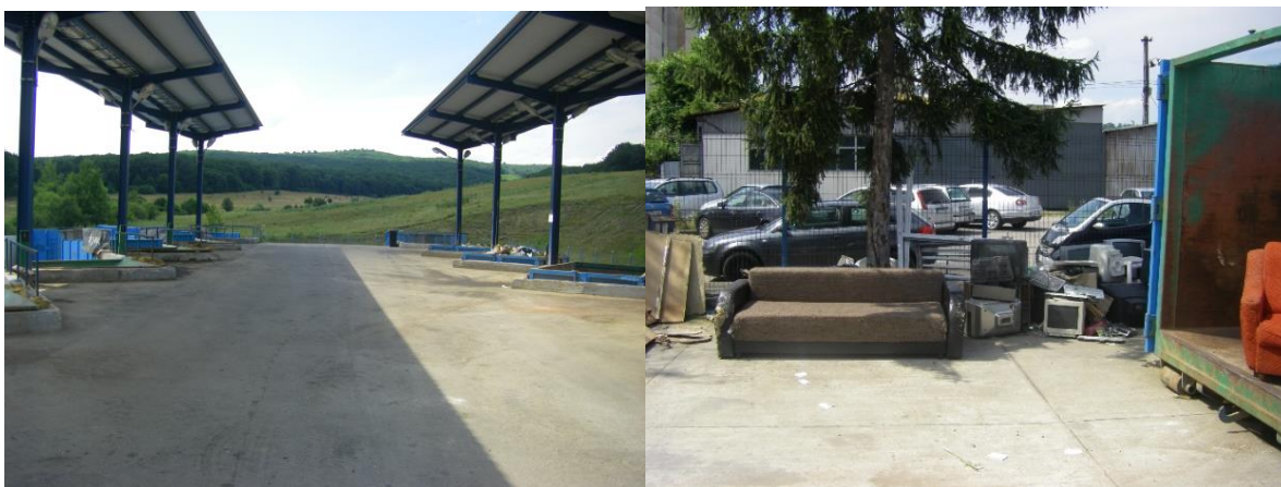
Figură 2-9 Stația de transfer și Centrul de colectare
